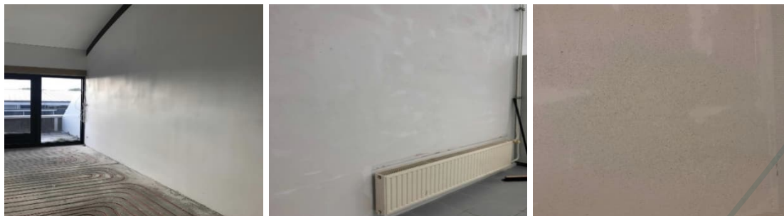
Foto 1: Nieuw pleisterwerk, glimmend, dicht en vlak
