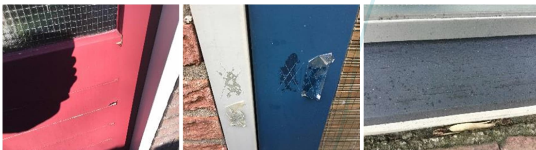
Foto 1: Afbladdering en sterke verpoedering. Deur met zwaardere kleur sterk verkleurd
