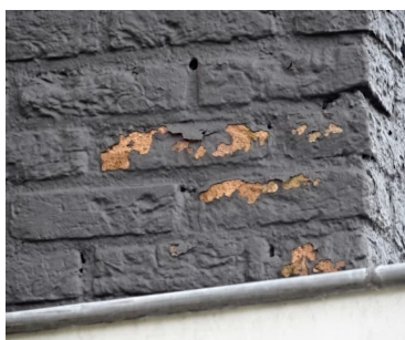
Foto 1: Monumentaal pand. Verfsysteem heeft plaatselijk schade.
