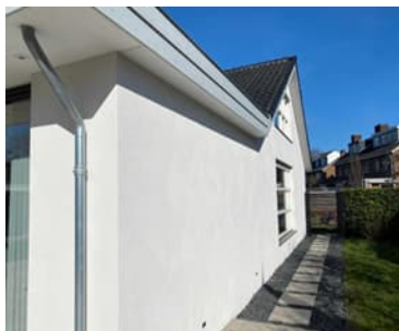
Foto 1: Nieuw pleisterwerk buitengevelisolatie.
