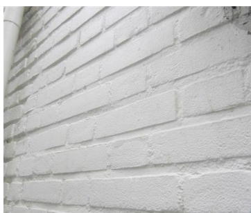
Foto 1: Monumentaal pand. Verfsysteem heeft plaatselijk schade.
