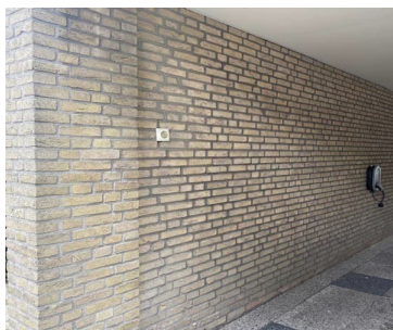
Foto 3: Metselwerk enigszins vervuild, (te) dicht op maaiveld.
