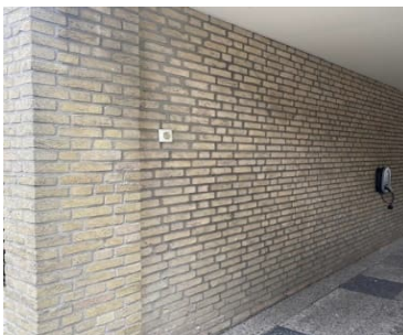
Foto 3: Metselwerk enigszins vervuild, (te) dicht op maaiveld.
