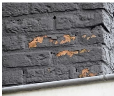
Foto 1: Monumentaal pand. Verfsysteem heeft plaatselijk schade.
