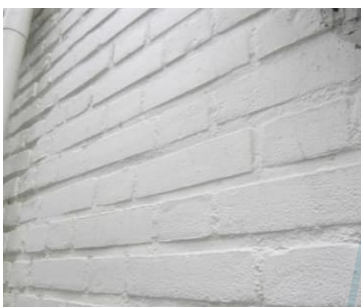
Foto 1: Monumentaal pand. Verfsysteem heeft plaatselijk schade.
