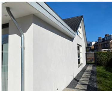
Foto 1: Nieuw pleisterwerk buitengevelisolatie.
