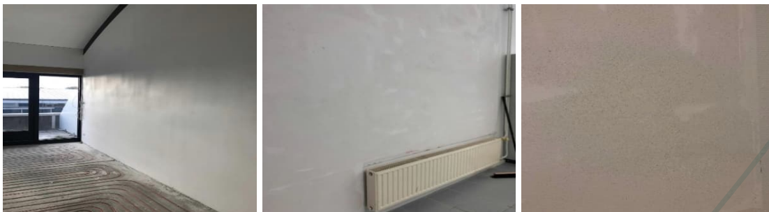
Foto 1: Nieuw pleisterwerk, glimmend, dicht en vlak
