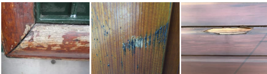
Foto 1: Volledige onthechting. Verweerd hout. Open verbindingen. Foto 2: Mechanische schade aan de laklaag en verweerd hout. Regelmatig voorkomend. Foto 3: Sterke onthechting van alle verflagen tot op het blanke WRC hout.
