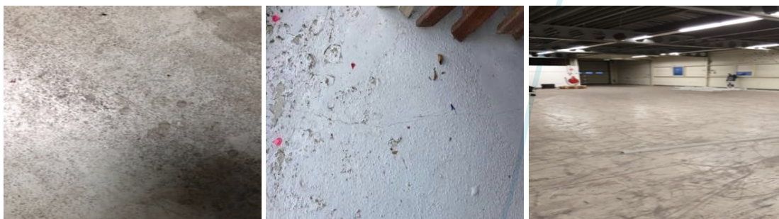
Foto 1: Diktekanen met veel mos-en alg vervuiling, verfsysteem heeft plaatselijk schade.
